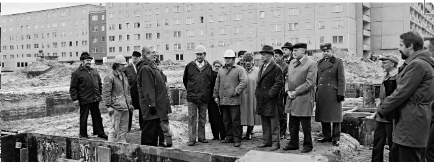
Grundsteinlegung des Würfelhauses, 1986 Copyright by Klaus-Peter Matte
