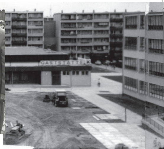
Baustelle am Platz vor dem Ambulatorium, 1988 Copyright by Rainer Schubert
