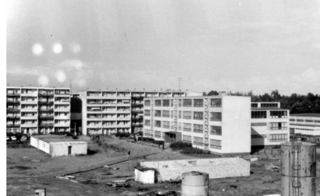
Baustelle vor der 7. POS Karl-Marx, 1983 Copyright by Rainer Schubert
